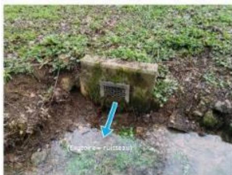
Sortie/ exutoire de la conduite fonte DN 150 depuis le canal avec batardeau.
