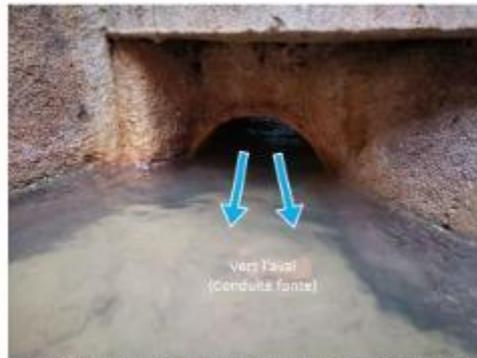
Arrivée de l'eau depuis le cuvelage de dissipation par une conduite fonte DN 200
