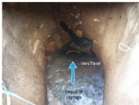
Arrivée des eaux vers un cuvelage de dissipation puis vers une conduite en fonte DN 200
