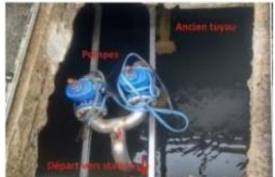
[Figure 6 : vue du sommet des deux pompes immergées](#)
