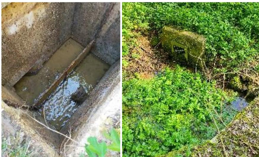
Figure 10 : regard en béton avant le trop-plein des eaux en direction du ruisseau du Chamoux (à gauche) et exutoire du trop-plein (à droite)
